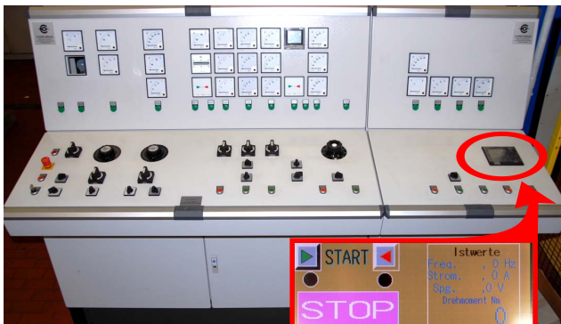
Bedienpult des Prüffeldes mit Mitsubishi Electric Touch-Bedien- und Anzeige-Panel
